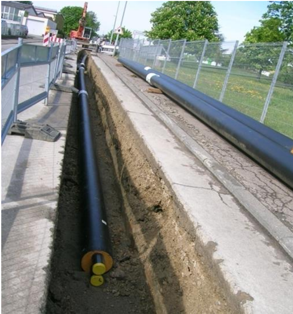
Verlegung KMR-Doppelrohr
