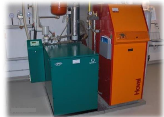
Blockheizkraftwerk
